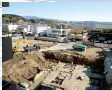
土工事 (平成24年1月26日撮影)
