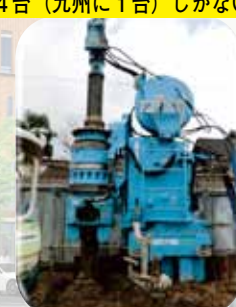
ゼロパイラー圧入工法 (ZERO PILER ECO600S)
