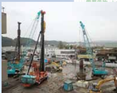
掘削・杭工事 (平成23年12月8日撮影)
