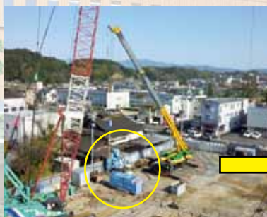
境界部山留工事 (平成24年4月4日撮影)
