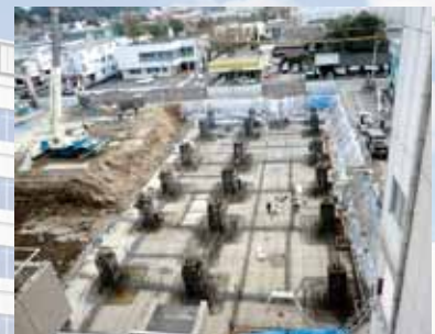
基礎躯体工事① (平成24年2月17日撮影)
