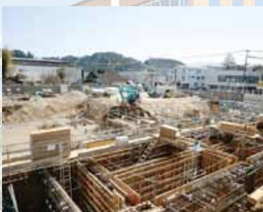
基礎躯体工事② (平成24年3月14日撮影)
