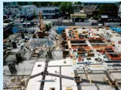
基礎躯体工事③ (平成24年5月11日撮影)
