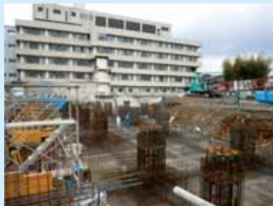
基礎躯体工事① (平成24年4月3日撮影)
