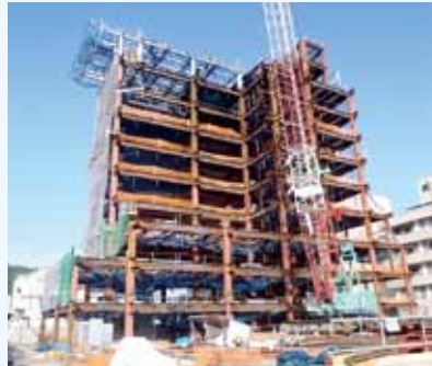
鉄骨建方② (8/31)
