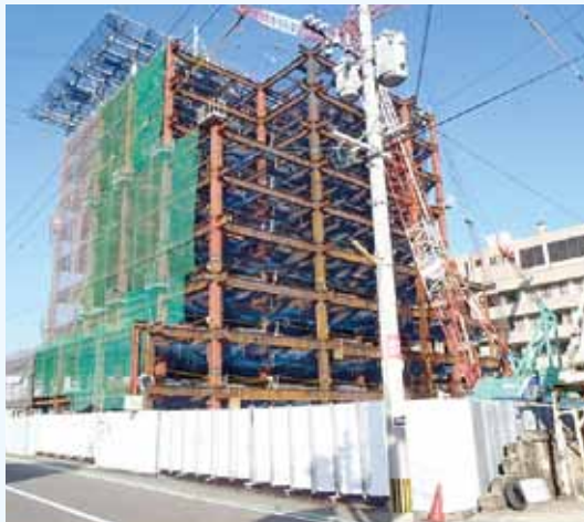
鉄骨建方④ (9/27)
