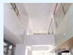
(1 F エレベーター吹抜け 3/16)
